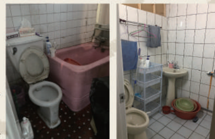
修繕前 & 修繕後 ▶
